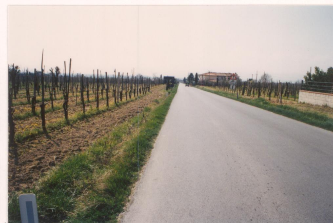
p.v. N.6. Lo "Stradone" verso Pod. La Croce.....
