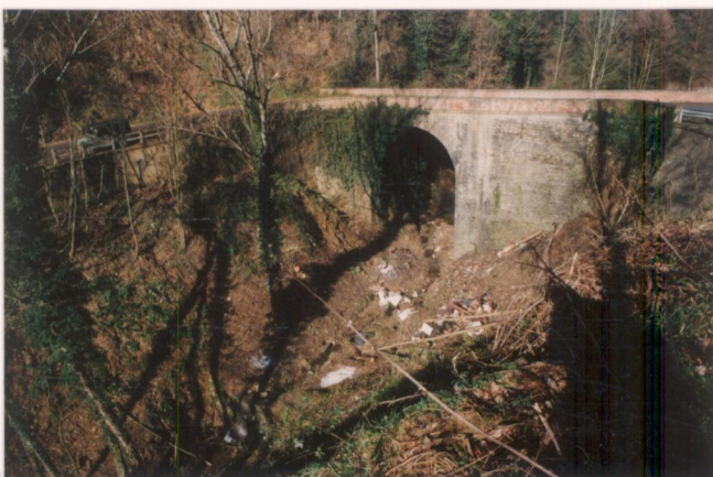
p.v. N. 11. Ponte sul Borro di Montemarciano.....
