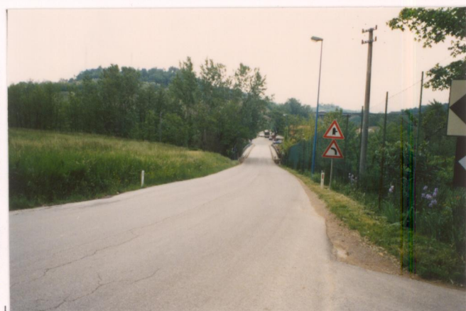
p.v. N. 1. Verso il Ponte dell'Acqua Borra.....
