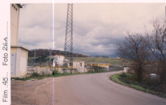
p.v. N. 6. Depuratore
