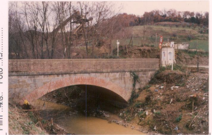
p.v. N. 16...Ponte sul Fiume Faella
