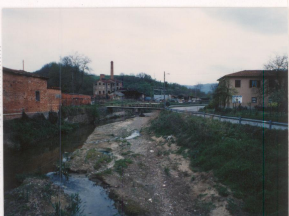
p.v. N. 23. La strada dal ponte sul Vacchereccia
