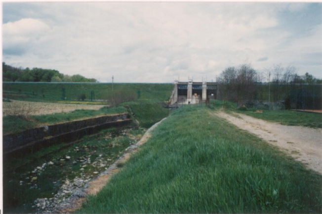
p.v. N. 11...Diga del lago di S. Cipriano.....
