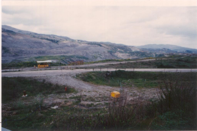
p.v. N. 9. Massa dal Ponte di Castelnuovo
