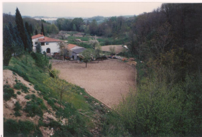
p.v. N. 3 Veduta del Ponte.....
