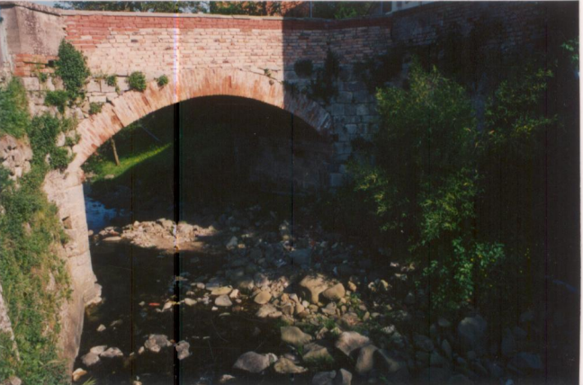
p.v. N. 20. Ponte sul Borro di Cammenata.....
