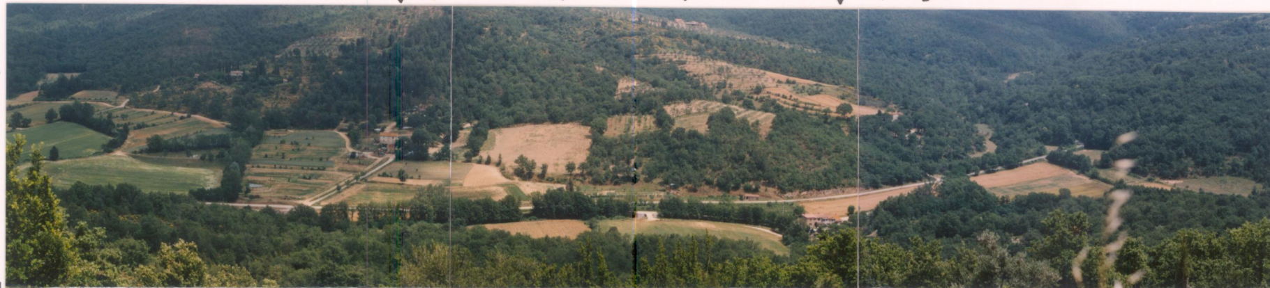
p.v. N.1. Panoramica della Strada vista da Sogna
