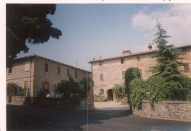
p.v. N. 15. Palazzino; fronte sulla strada provinciale
