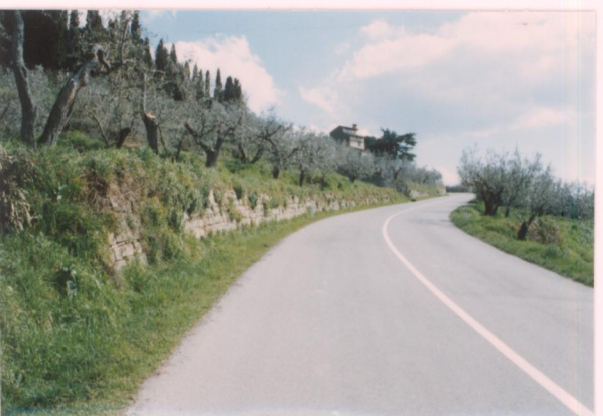
p.v. N. 13. sistemazione a terrazzo con muretti a secco.
