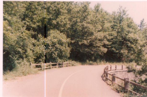
p.v. N. 25 Ponte sul Fosso Maggiore.....
