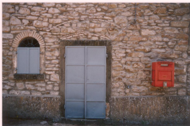
p.v. N. 14 Novelle : particolare del fronte sulla strada
