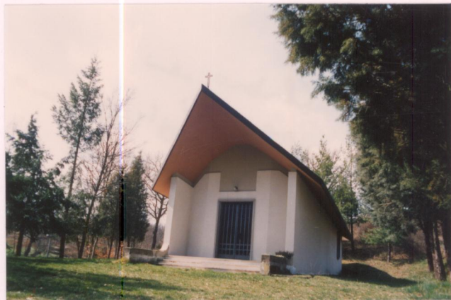
p.v. N. 9 Chiesa nuova nei pressi della strada
