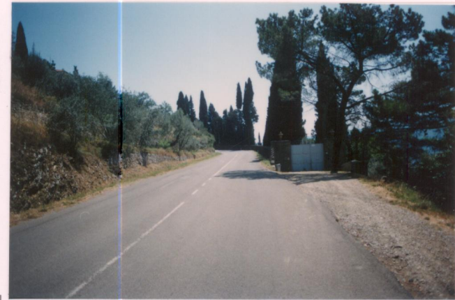
p.v. N. 10. sul lato sinistro i muretti dei terrazzi.....
