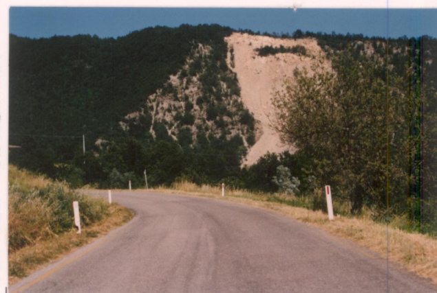
p.v. N. 23. Frana sul fianco ovest della Balza di S. Francesco
