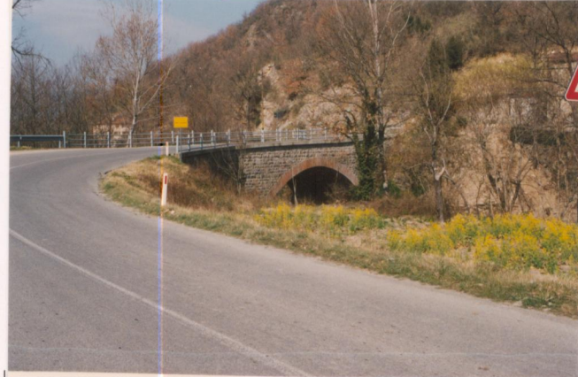
p.v. N. 2 Ponte sul torrente Rassina
