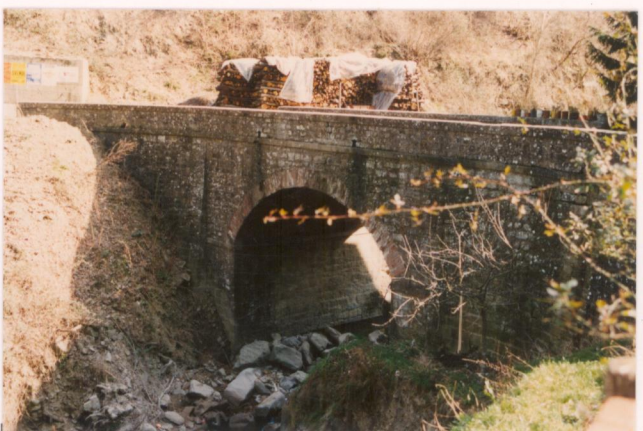
p.v. N. 3 Ponte sul fosso delle Trafigge
