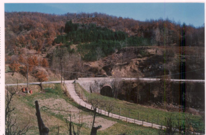
p.v. N. 5 Ponte sul fosso della Preta
