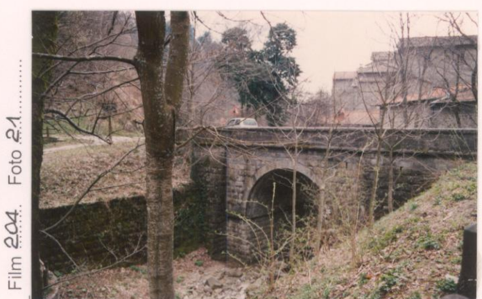
p.v. N. 18. Ponte sul Fosso di Camaldoli
