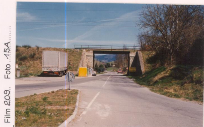
p.v. N. 2. Il sovrappasso della ferrovia.....
