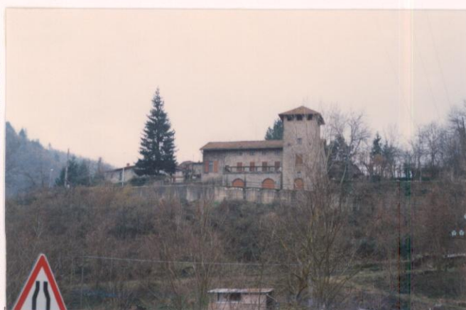
p.v. N. 15. Edificio storico a Villa Mezzetti.....
