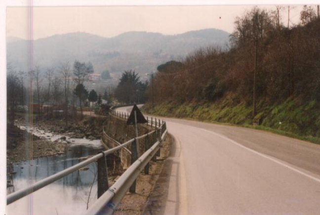
p.v. N. 13. Il tracciato stradale a Strapiombo sul Solano.....
