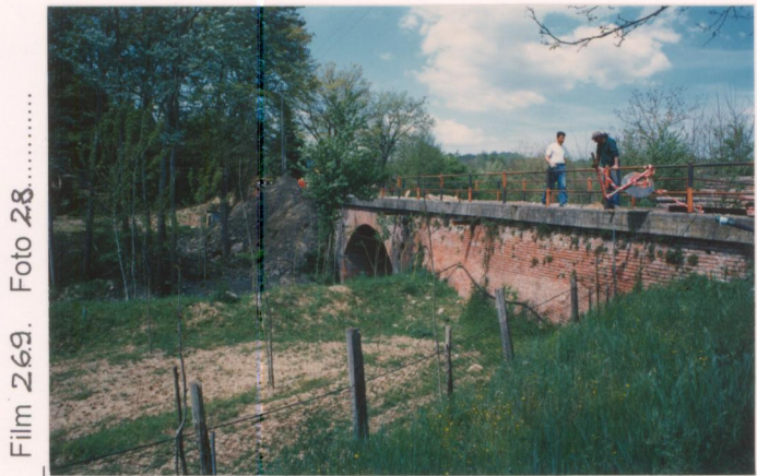
p.v. N. 17. Ponte sul Borro del Giglio (Strada per La Selva)
