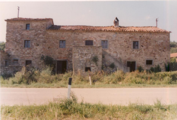
p.v. N. 16 Edilizia rurale lungo strada
