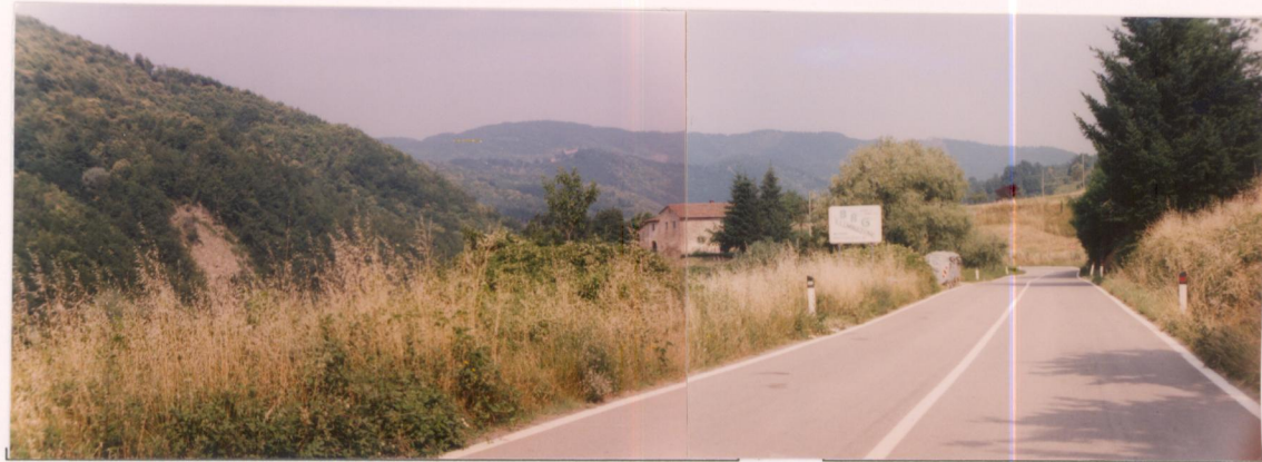
p.v. N. 8 Verso Prato: sul versante collinare a sinistra è visibile una piccola frana
