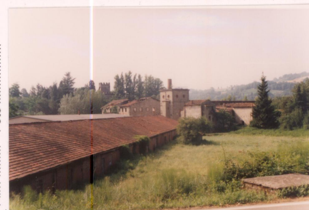
p.v. N. 2. Vista verso il Lanificio di Stia
