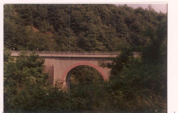
p.v. N. 16 Ponte sul fosso di Genio
